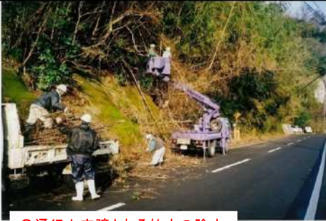
○通行上支障となる竹木の除去
