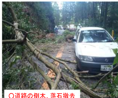
○道路の倒木、落石撤去
