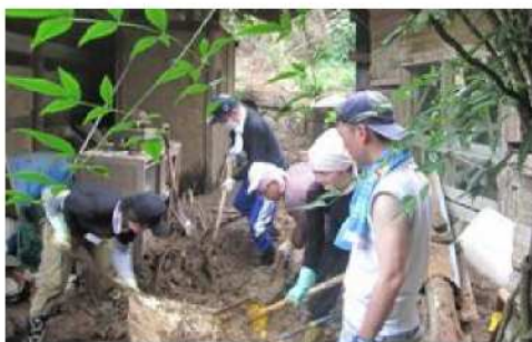
○人力による被災家屋内の土砂除去
