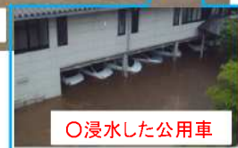
○竹田土木事務所
