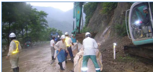
道路啓開・土石流処理(岩手県建設業協会)
