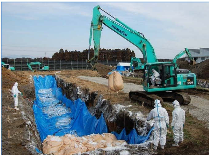
家畜埋却作業(宮崎県建設業協会)
