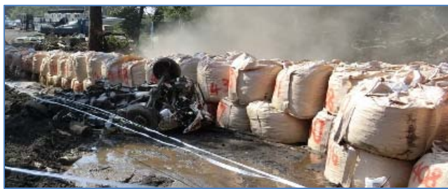
土のう設置状況(東京建設業協会)
