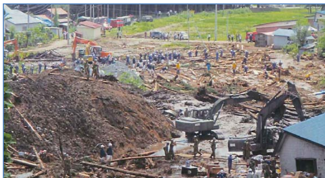
土石流撤去作業(秋田県建設業協会)
