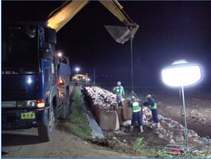
大型土のう設置作業(熊本県建設業協会)
