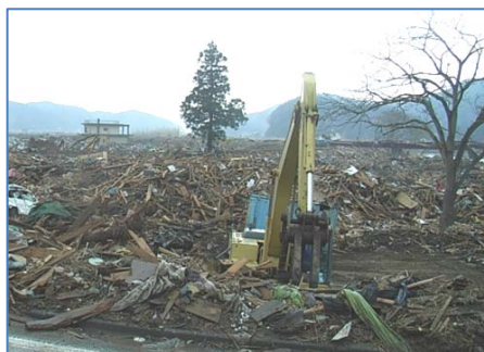
陸前高田市 瓦礫撤去作業(岩手県建設業協会)
