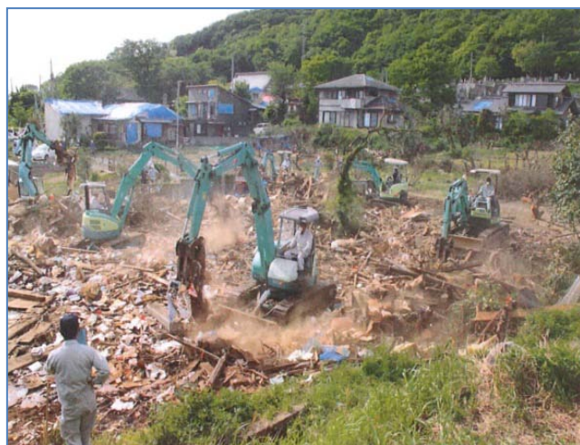
瓦礫撤去作業(茨城県建設業協会)
