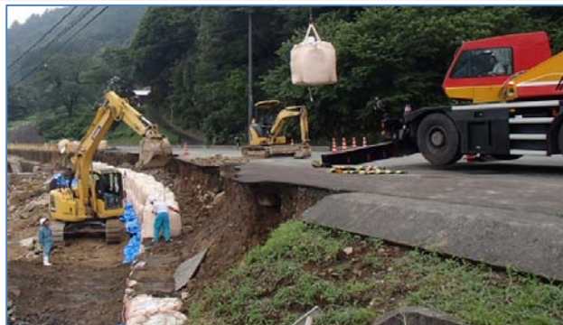
道路崩壊復旧作業(山口県建設業協会)
