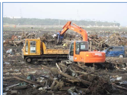
南相馬市 瓦礫撤去作業(福島県建設業協会)
