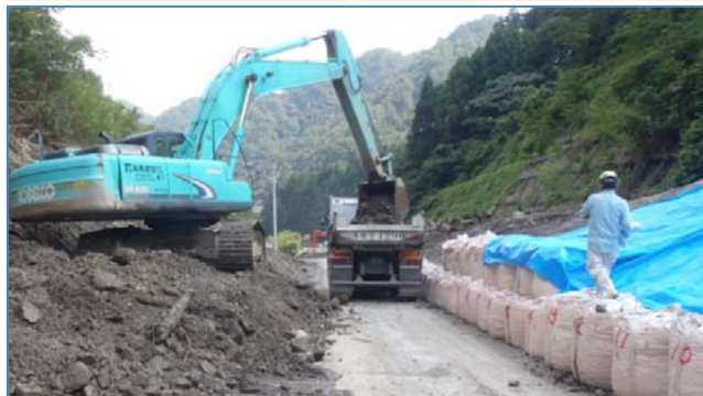
法面崩落復旧作業(島根県建設業協会)
