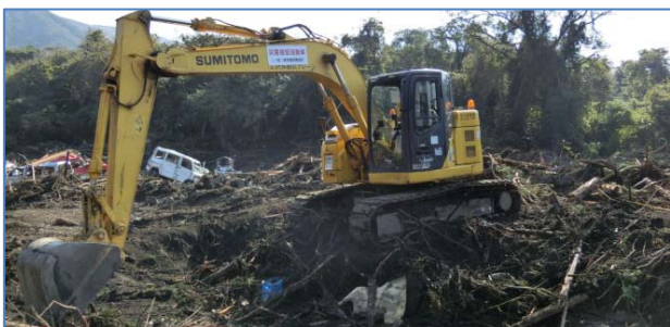
土石流撤去作業(東京建設業協会)
