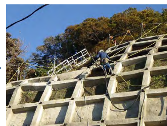
中詰材設置、アンカー設置(R2)
