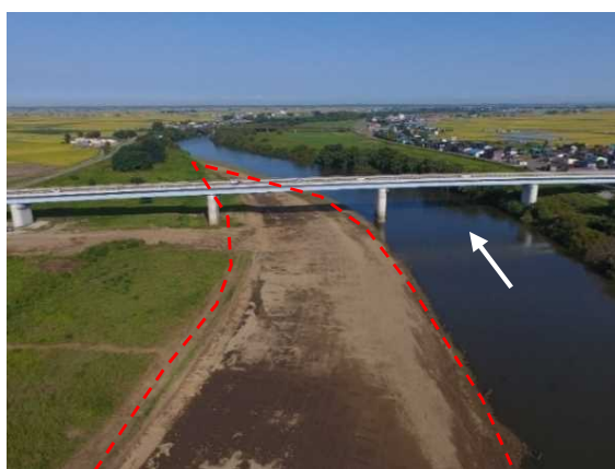
樹木伐採・河道掘削実施中(H30補正)
