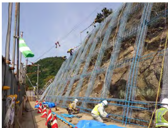
法枠施工(R1)
